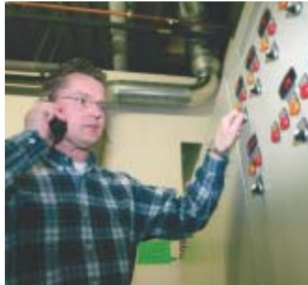
Heifo-Mitarbeiter vor Ort an einer Kundenanlage
